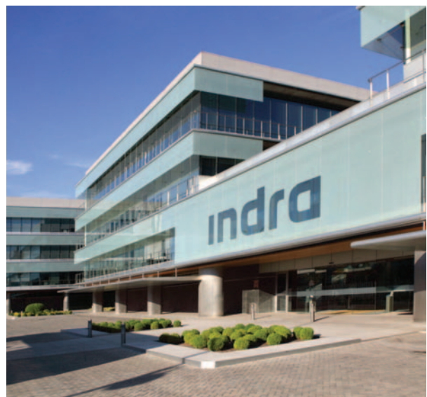
Puerta principal sede central Indra.
