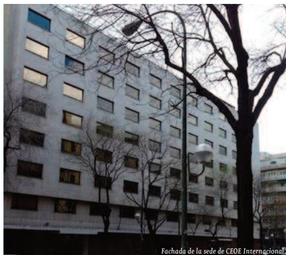
Fachada de la sede de CEOE Internacional.
