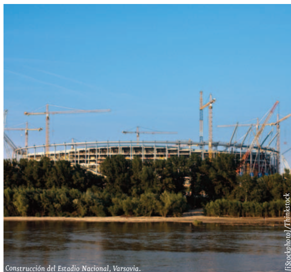
Construcción del Estadio Nacional, Varsovia.
