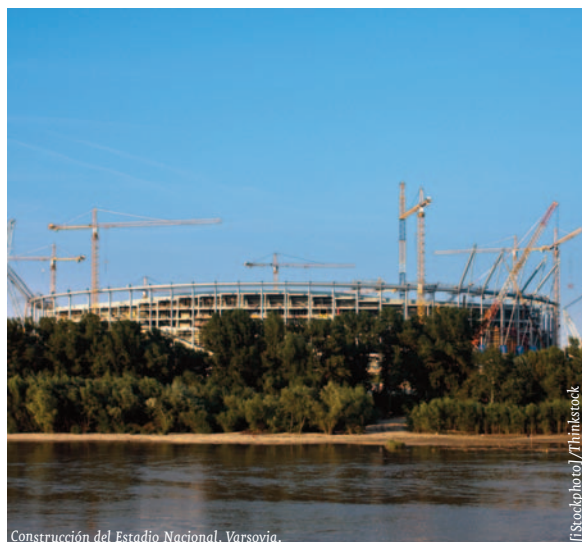
Construcción del Estadio Nacional, Varsovia.
