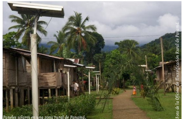
Paneles solares en una zona rural de Panamá.
