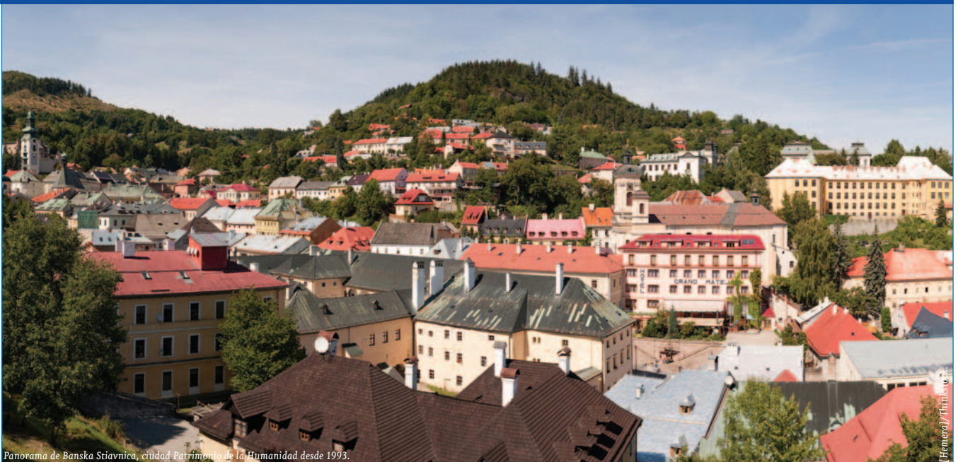
Panorama de Banská Štiavnica, ciudad Patrimonio de la Humanidad desde 1993.
