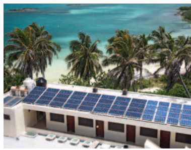
Edificio con panel solar en la Isla Contoy, México.
