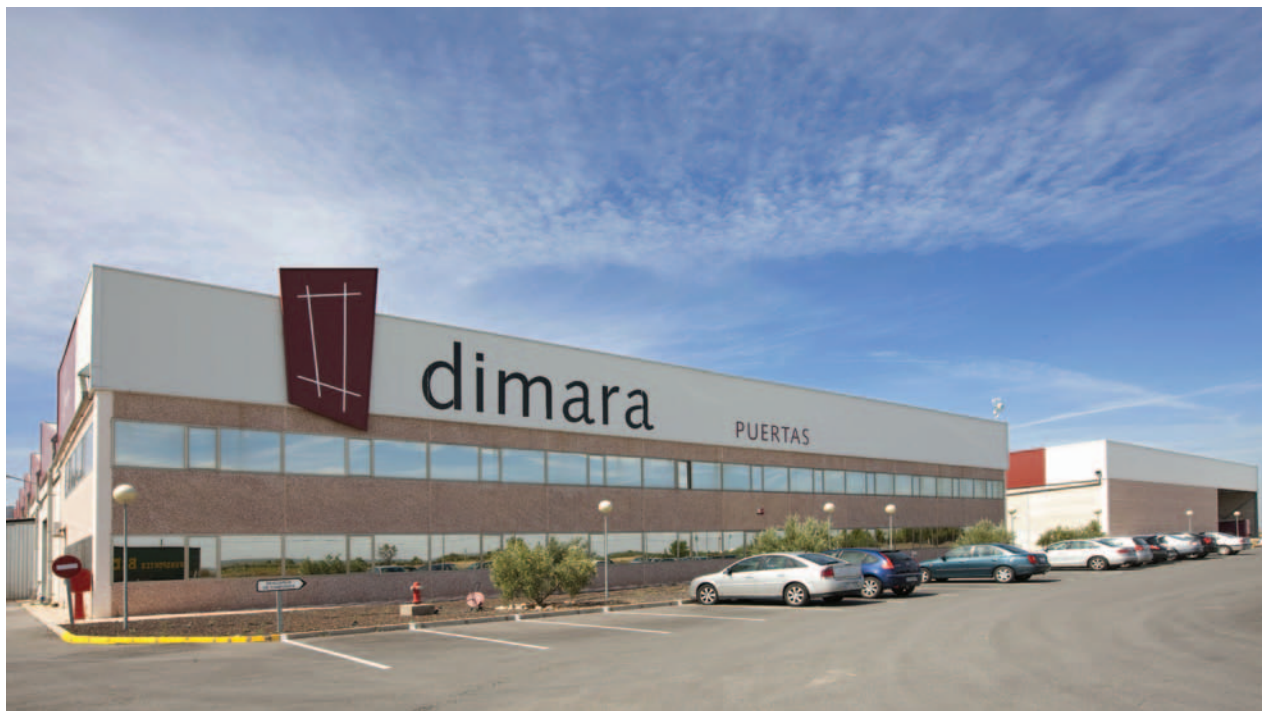
Fachada de Puertas Dimara.
