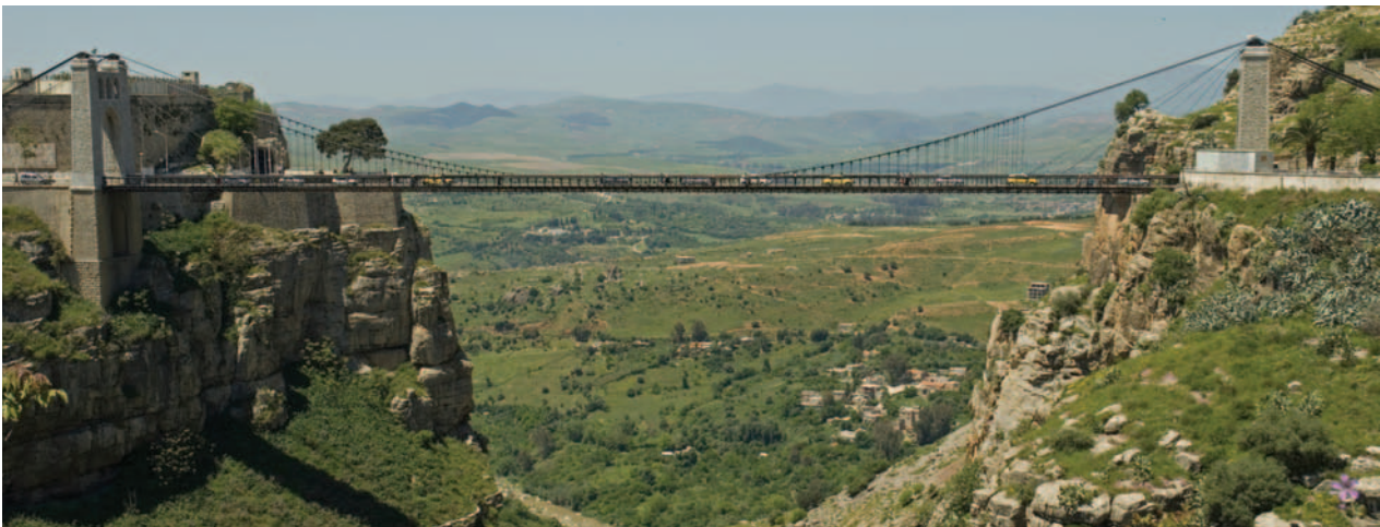
Puente de Sidi M'Cid en Constantina, Argelia.
