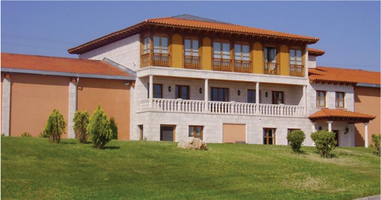
Fachada de Bodegas Imperiales.
